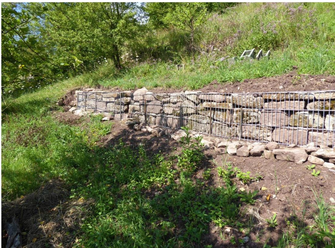
Abbildung 8: Neuangelegte Trockenmauer
