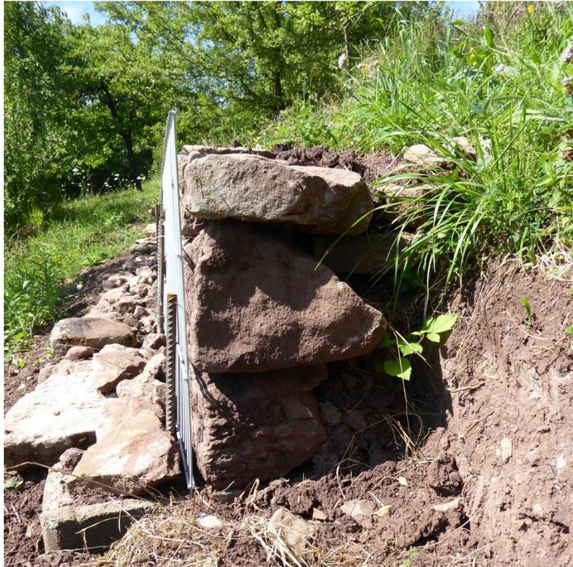
Abbildung 9: Querschnitt einer Trockenmauer im Ersatzhabitat
