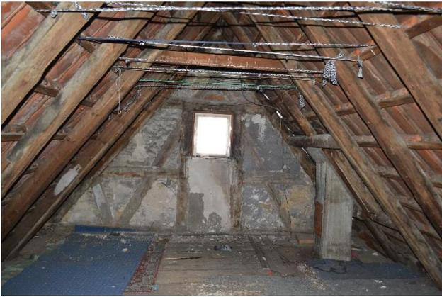
Abb. 14 bis 18: Blick in die unterschiedlichen Dachböden der Wohn- und Geschäftsgebäude. Allen Wohn- und Geschäftsgebäuden ist die fehlende Isolation der Dachgeschosse gemeinsam. Es gibt in den Dachbereichen kleine Lücken und Spalten, so dass die Möglichkeit für das Einfliegen von Tieren besteht.
