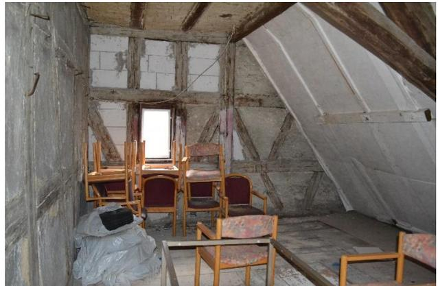
Abb. 19: Detailansicht der Decke in Gebäude Marktstraße 27. Diese besteht aus Lehm mit Stroh (s.a. Abb. 18).
